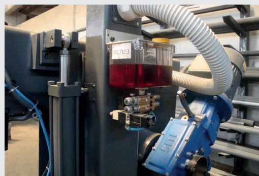
Système de refroidissement
